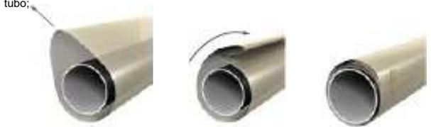
Paso 7: Asegure el doblez de la manga de PE a lo largo de la dirección axial del tubo con cinta adhesiva a cada metro;
