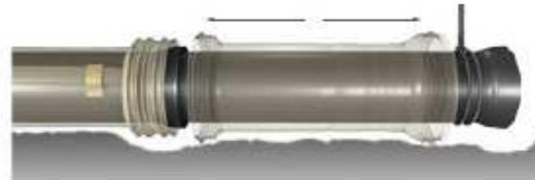
Paso 4: Jale el exceso de manga de PE al costado del extremo de la campana, envuelve la tubería en las juntas y usa cinta adhesiva para asegurarlo en su lugar;
